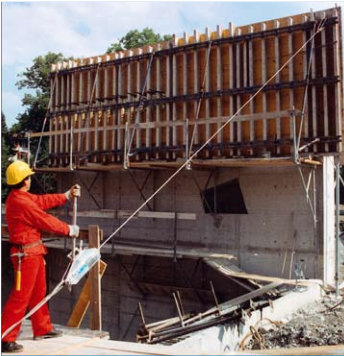
Sicherung einer Betonschalungswand Consolidation d'un mur de coffrage en béton Securing a formwork wall
